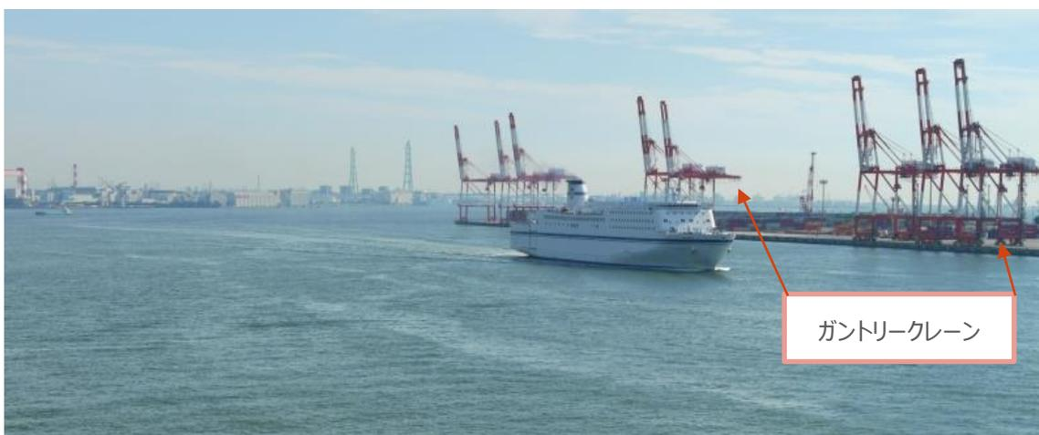
名古屋港に入港中の長距離フェリーと、コンテナを積み降ろしするためのガントリークレーン。コンテナ船の荷役がない時には、ブーム(BOOM)を持ち上げていないため巨大なキノコの様に見える。
