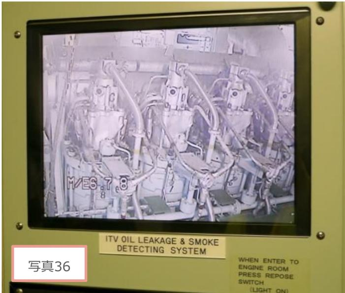
ちなみにエンジンルームの様子は、ブリッジにおいても左の写真36の様なモニターを用いて油の漏洩や煙の探知をすることができる。
