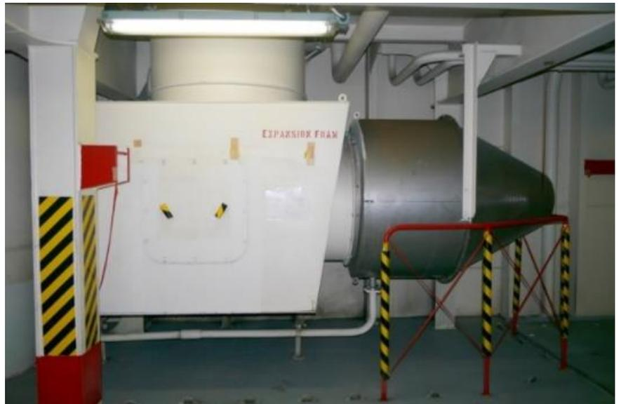
従来は炭酸ガスにて消火する方式であったそうだが、その方法だと火災区画を密閉し、酸欠状態を作り出し消火するため区画内に人が残っているかの安全確認で初動が遅くなる、区画の車両がすす等で使い物にならない等の問題があった。しかし、写真のような消火装置だと、人員・車両両方に対して無害であること、火災区画を密閉する必要がないこと、また初期消火が炭酸ガスと比較して容易である等といったメリットがあるという。
